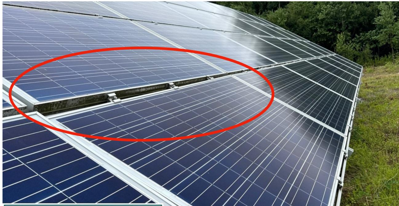
雪の重量によりパネルが破損
